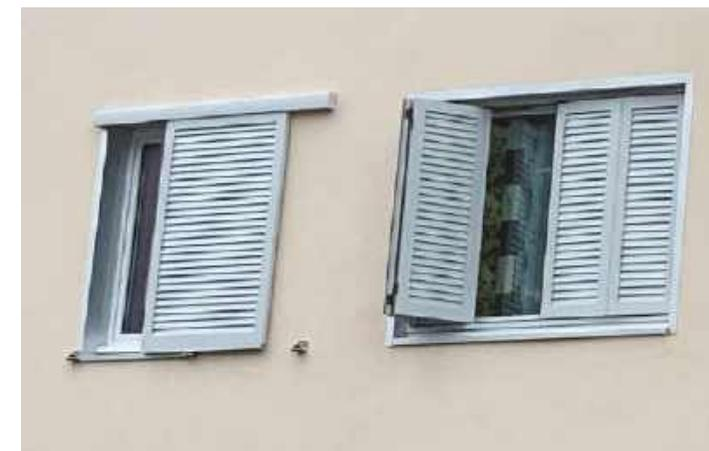
Tout en aluminium thermolaqué, cette persienne se compose de lames en aluminium extrudé articulées dans un cadre qui se replie en accordéon dans l'épaisseur ou l'extérieur du tableau.
