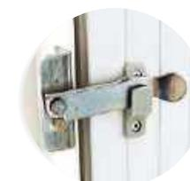
Arrêt de persienne avec arrêt à vent PVC (en option)
