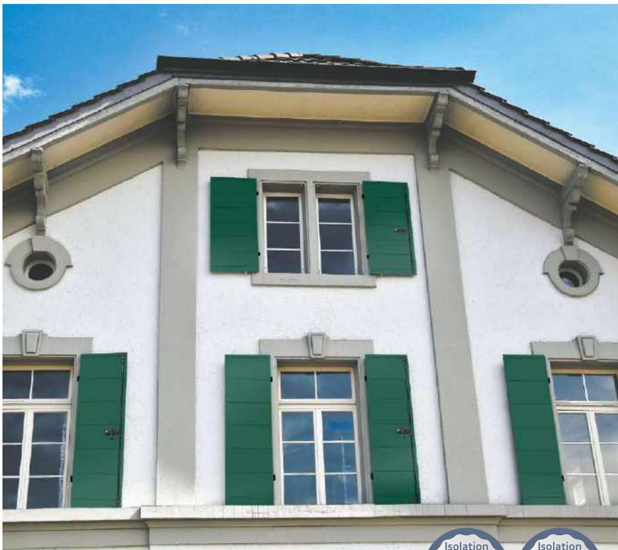
Lames horizontales en aluminium isolé (27 mm).
