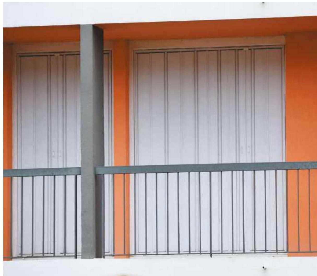
Panneaux composés de vantaux pvc alvéolaire de 14 mm d'épaisseur, cadre aluminium.
